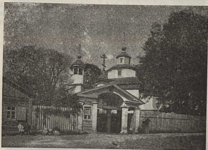
Единѣвѣрчовская церковь св. пророка Иліи.
