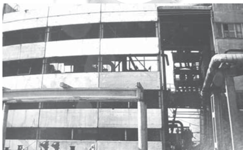
Строительство новых корпусов завода, 80-е годы
