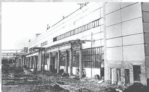
Строительство новых корпусов завода, 80-е годы
