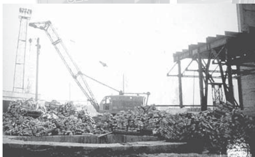
Строительство новых корпусов предприятия, 80-е годы
